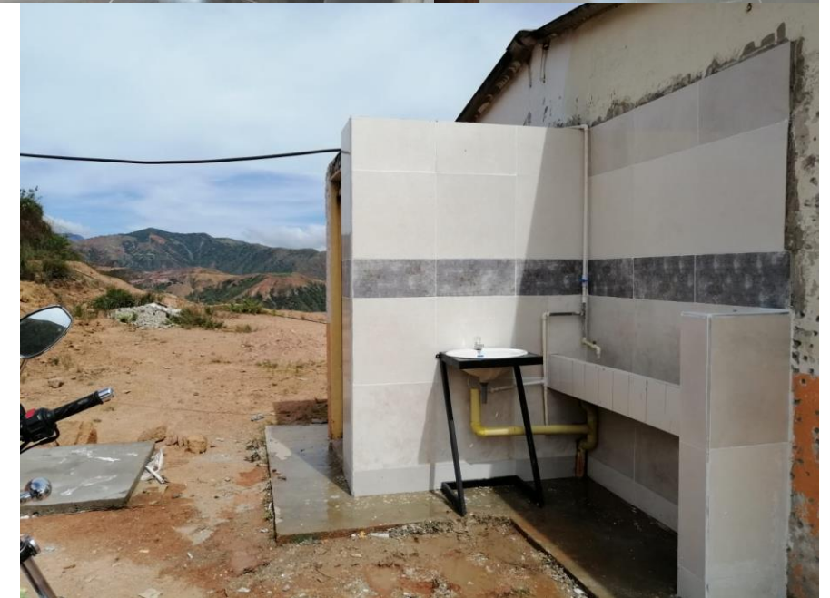
Después de la obra
